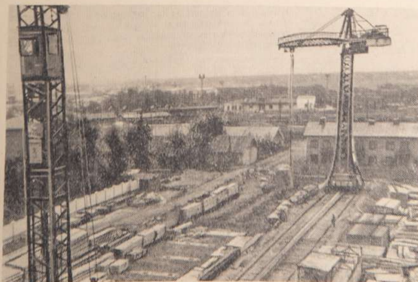
Здесь главный корпус заложен
