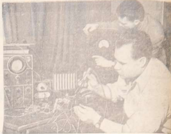
На снимке: студенты V курса РТФ Ю Александров и В. Заборон для сборки приемника на полупроводниковых транзисторах
