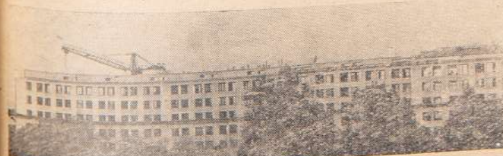
ГЛАВНЫЙ КОРПУС СТРОИТСЯ
