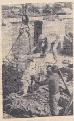
И под нашими руками стены вырастают. Фото В. ПРИШЕДЬКО.
