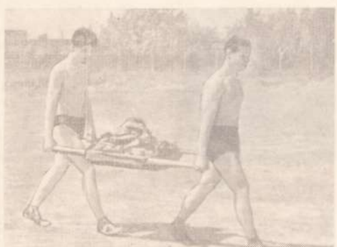
Студенты V курса агрохимического факультета Юрий Тумашев (слева) и Александр Шаров работают на строительстве стадиона.
