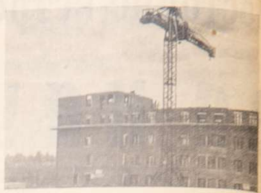
Идет надстройка лабораторного корпуса.
